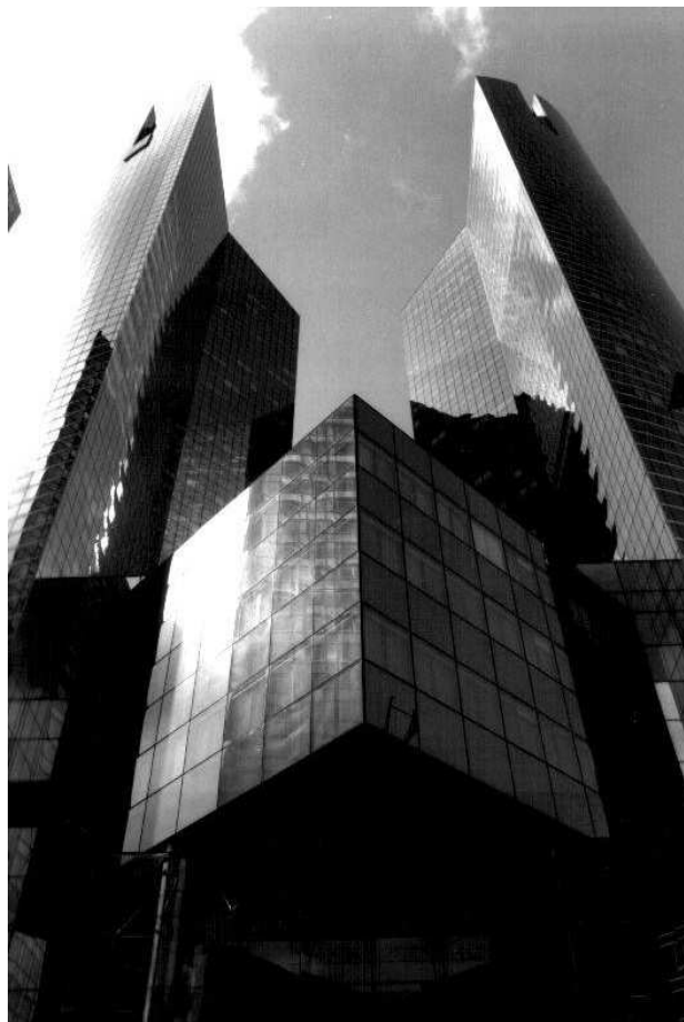
Abbildung 3.1: Hochhäuser in La Defense
