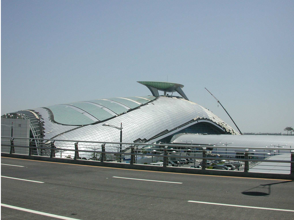
Abbildung 12: Freiformfläche zur Überdachung der Ankunftshalle Incheon Airport, Seoul Korea
