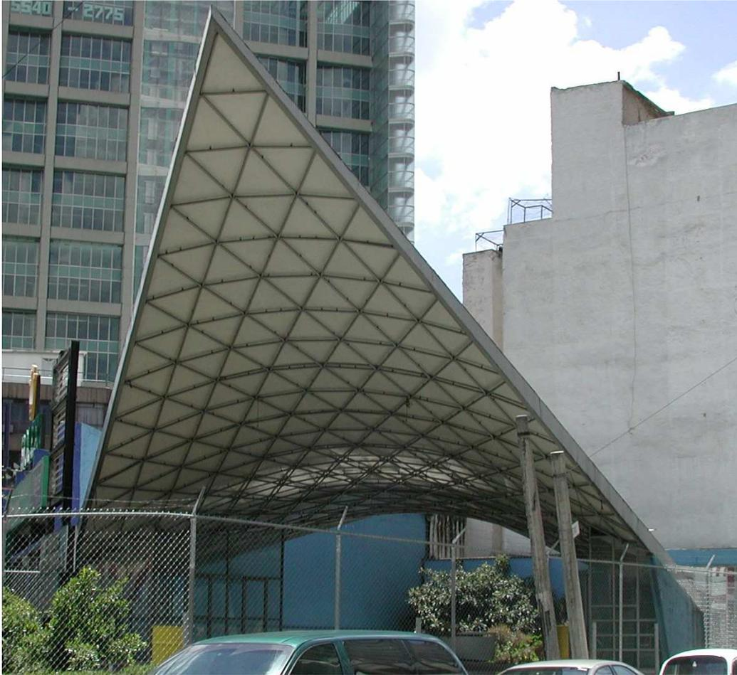
Abbildung 19: Hyperbolisches Paraboloid
