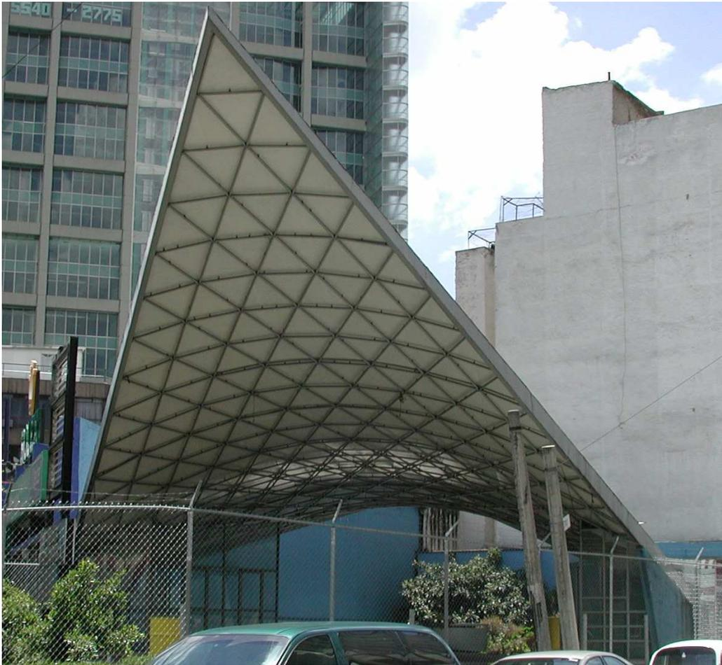
Abbildung 4.6: Hyperbolisches Paraboloid
