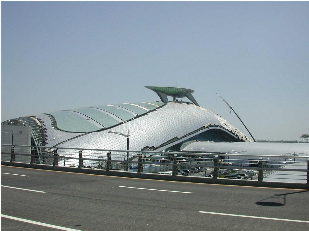
Abbildung 4.12: Freiformfläche zur Überdachung der Ankunftshalle Incheon Airport, Seoul Korea
